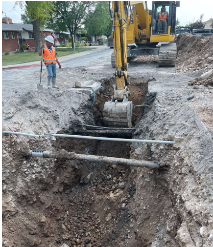
ADA Ramp Project
